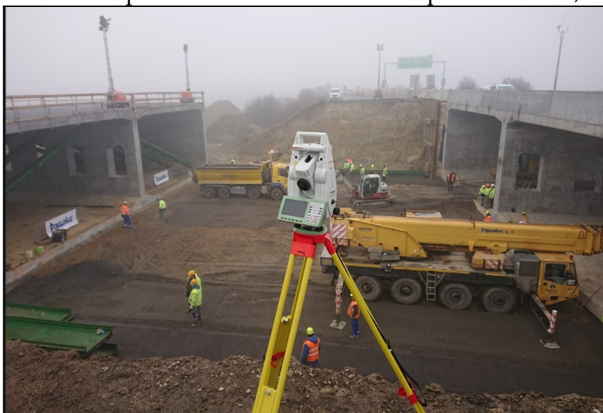
Obr. 7 Príprava na presun pravého mostného DC
