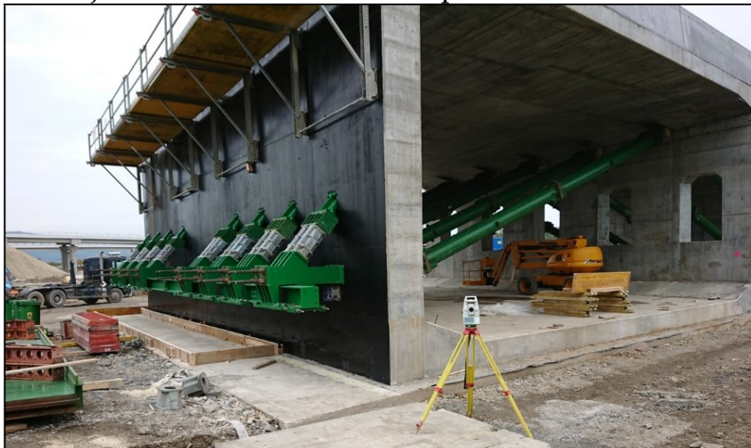
Obr. 5 Montáž technológií na ľavý mostný DC
