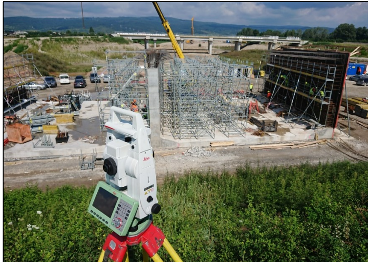
Obr. 4 Pohľad na výstavbu ľavého mostného DC
