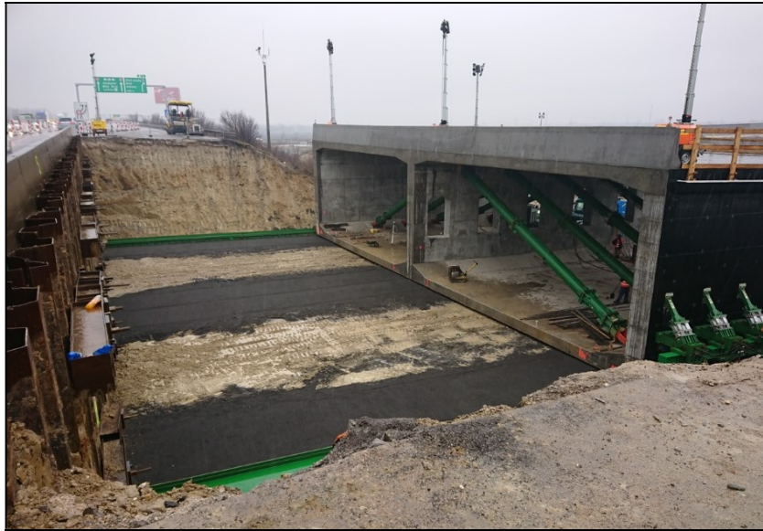
Obr. 6 Presun ľavého mostného DC
